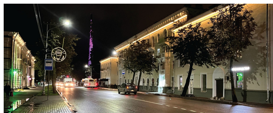
Устройство архитектурной подсветки
